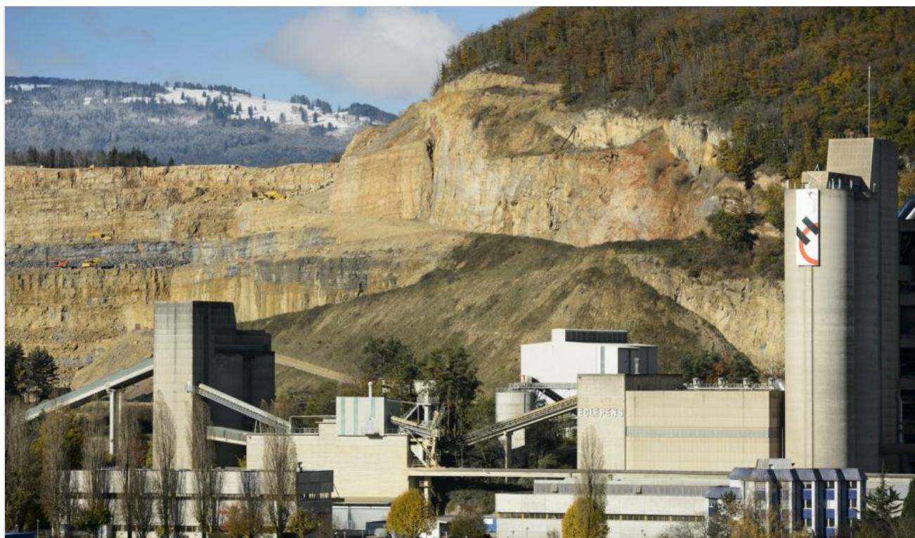
Le site cimentier d'Holcim à Eclépens est notamment dans le collimateur du collectif pour la sauvegarde du climat. KEYSTONE
